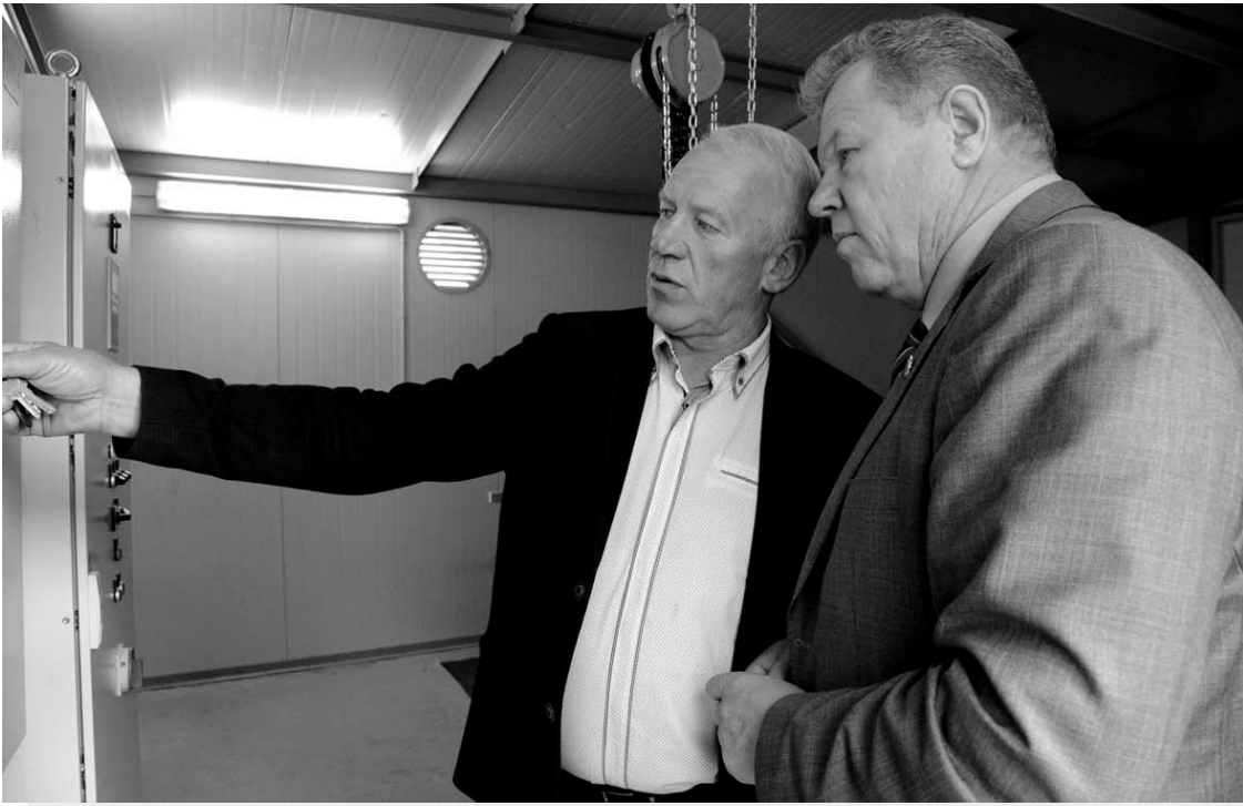
Kokį vandenį mes geriamo, domisi ir Anykščių rajono meras Kęstutis Tubis. Jis su UAB „Anykščių vandenys“ direktoriumi Arvydu Katuoka pernai pastatytoje ir patikimai veikiančioje Troškūnų vandens gerinimo įrenginiuose.
